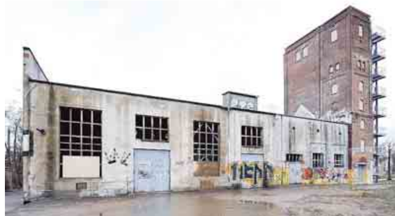
Die Hallen auf dem Andes-Gelände sollen weg.
